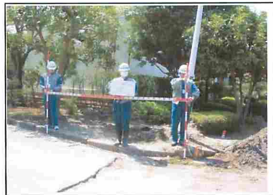
公園事務所 (照明灯の傾き)
