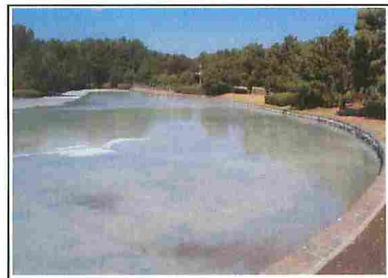
池底の防水機能が戻り、水の入った「浜の池」
