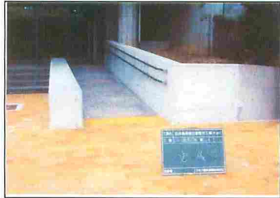
コンクリート擁壁打ち直し後
