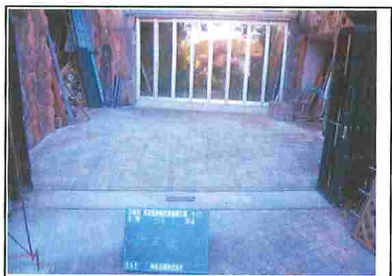
インターロッキングブロック舗装据え直し後
