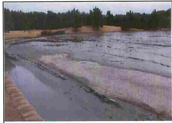
震災後の「浜の池」 防水機能が失われたため水がたまらない状態
