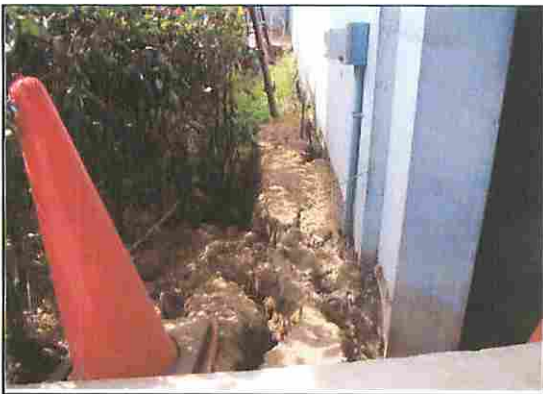
花の美術館レストラン前植栽帯 (地盤沈下)
