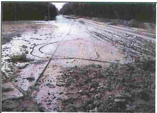
護岸道路(液状化による土砂噴出)
