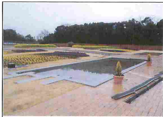
噴出土砂除去後、池の躯体の造り直し
