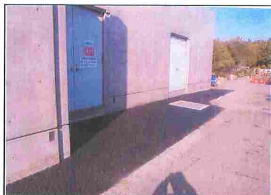
AS舗装打ち直し後
