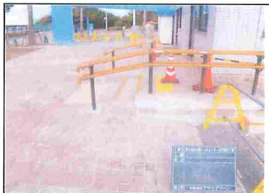
段差解消のために建物株への土の充填後 階段を設置
