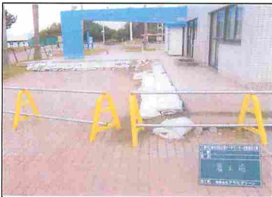
夏の海水浴時期には土嚢や板で仮設の 階段とスロープを設けて売店を営業
