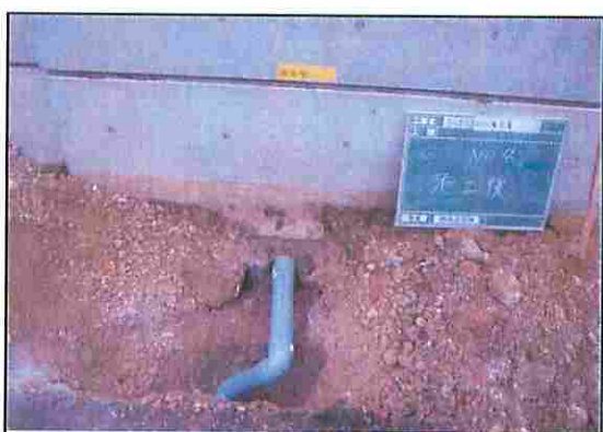
排水管の据え直し後
