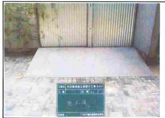
地盤沈下で生じた段差にスロープを設置
