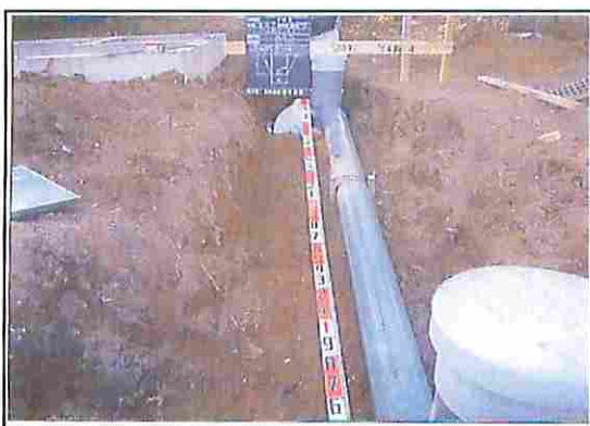
中磯辺公園 (復旧方法) 排水勾配を確保しながら、污水管の布設
