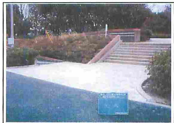
花見川緑地(復旧方法) 階段の下段、約4段を埋める形で舗装した
