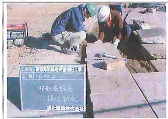
幕張海浜緑地(復旧方法) 基盤のコンクリート躯体から打ち直し、 その上に御影石を据え直した
