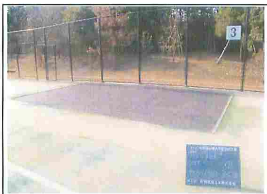
打瀬3丁目公園 テニスコート 人工芝 (復旧方法)隆起箇所の人工芝を撤去し、 原因となったAs舗装部分を舗装し直した
