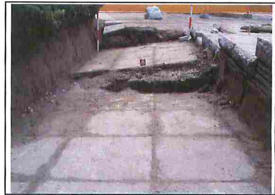
幕張海浜緑地(被害状況) 沈下したコンクリート基礎を撤去、打ち直し、 御影石を据え直した
