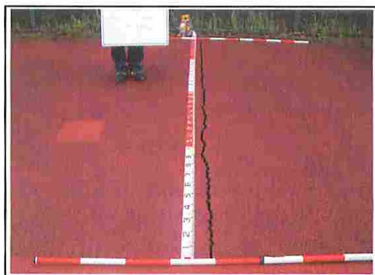
幕張海浜緑地 テニスコート ゴムチップ舗装 (被害状況)表層に部分的なクラック
