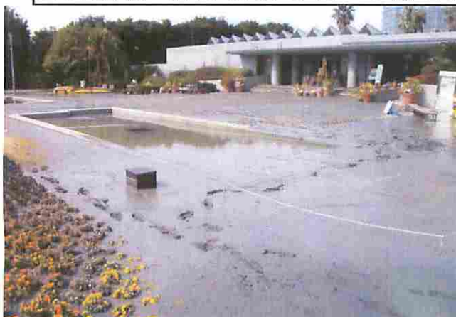
沈下・亀裂・液状化【美術館前レンガ舗装広場・噴水池破損】
