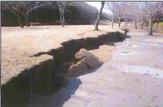
沈下・亀裂・液状化【芝生広場】
