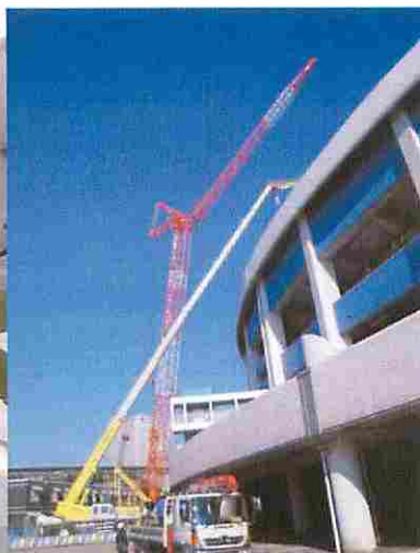
①屋根接合部及び ②夜間照明修繕状況
