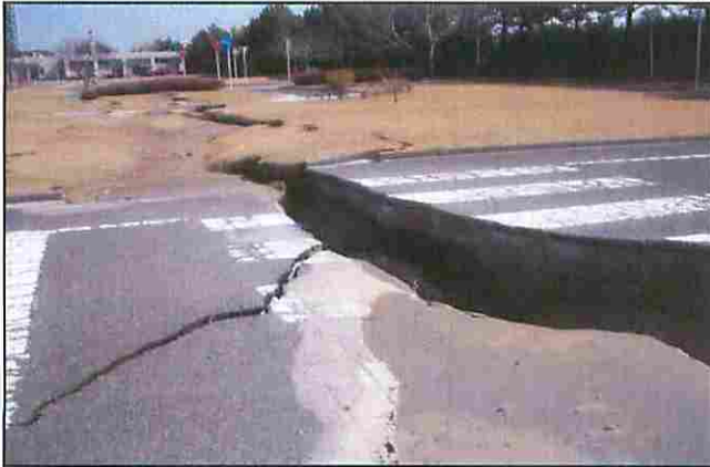
沈下・亀裂・液状化【交通公園アスファルト舗装園路】
