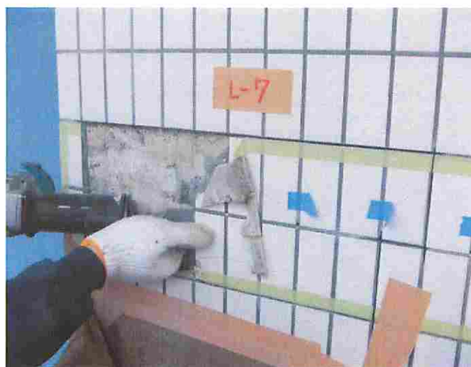
④外壁タイル破損(クラック、剥離)修理状況
