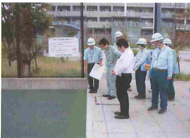
実地検査(打瀬3丁目公園) カラーアスファルト舗装・平板舗装復旧説明
