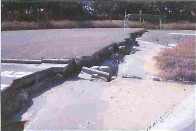
沈下・亀裂・液状化【交通公園インターロッキングブロック舗装広場】
