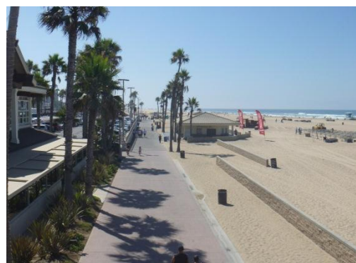
【園路及び砂止めの壁】
