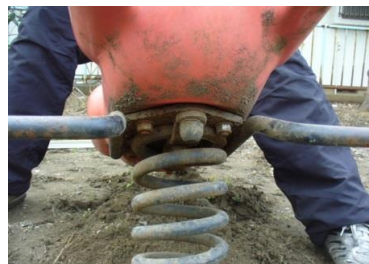
すべり台やスプリング遊具等の鉄部一部腐食
