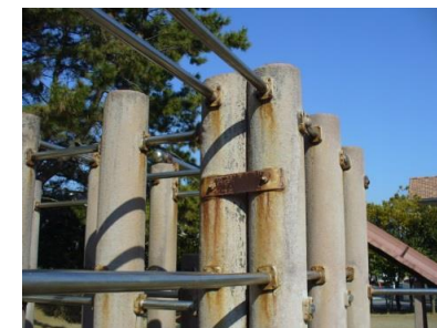
複合遊具の継手金具の腐食
