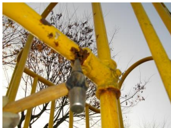
すべり台やスプリング遊具等の鉄部一部腐食
