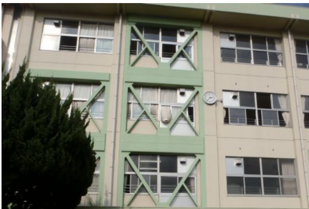
建物の耐震補強(星久喜中学校)
