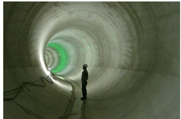
雨水貯留幹線
