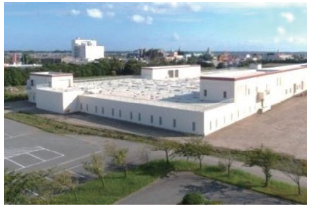
下水道の高度処理施設
