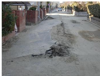
舗装の陥没・亀裂
