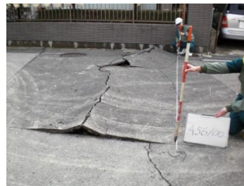
舗装の陥没・亀裂
