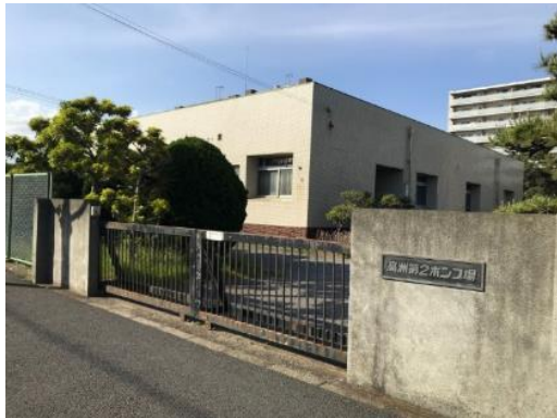
高洲第2汚水中継ポンプ場
