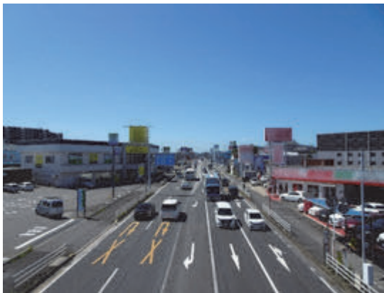
国道16号(長沼町付近)
