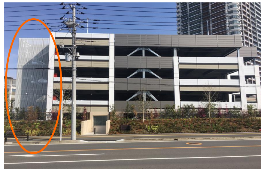
【目隠しルーバーあり】
