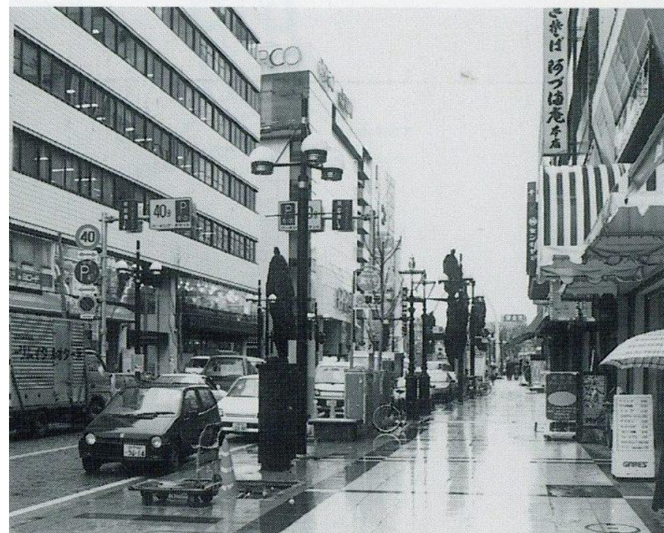
歩車道の整備 (平成2年完了)
