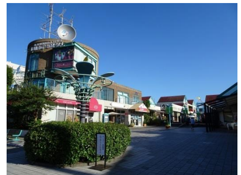
まちの玄関口としてにぎわいが感じられる土気駅前の商業施設
