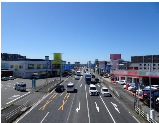
国道16号(長沼町付近)
