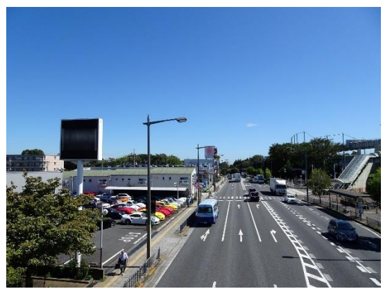
国道16号(穴川インターチェンジ付近)
