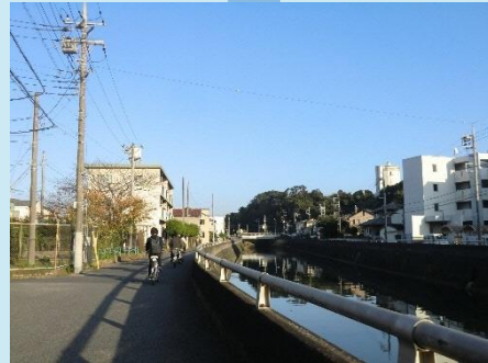
住宅地の中を抜ける コンクリート三面張り護岸の都川
