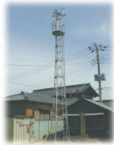
消火栓、火災報知器、望楼、警鐘台
