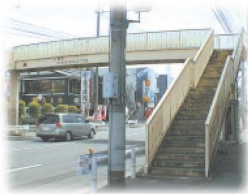
道路・鉄道等の橋りょう、歩道橋
