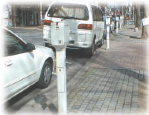
パーキングメーター・チケット発給設備
