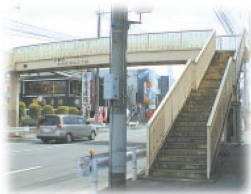
道路・鉄道等の橋りょう、歩道橋
