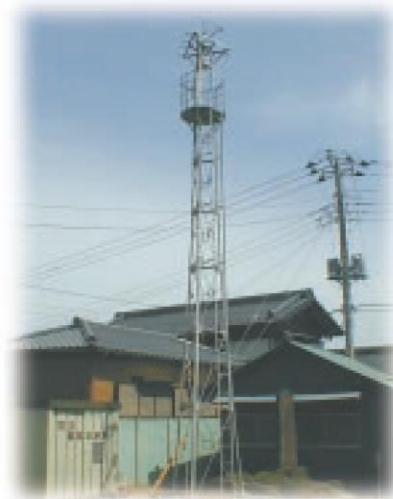
消火栓、火災報知器、望楼、警鐘台
