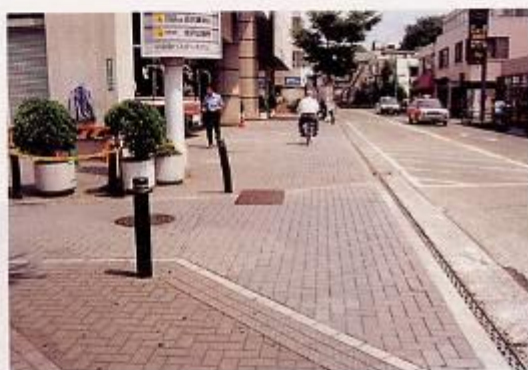
交差点部分で歩道の切り下げをつくらないように工夫している。 (東京・世田谷区／茶沢通り)
