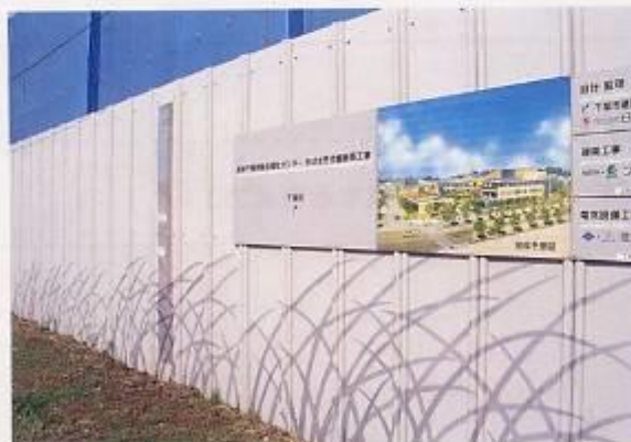
完成予想図を掲示するとともに、仮囲いを工夫し、工事の状況が見えるようにしている。 (千葉市／ハーモニープラザ)
