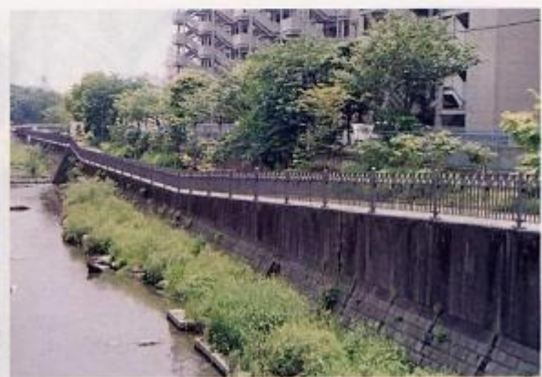
河道の地形に変化を与えて生息空間の創出を図っている。（神奈川・横浜市／独（いたち）川）
