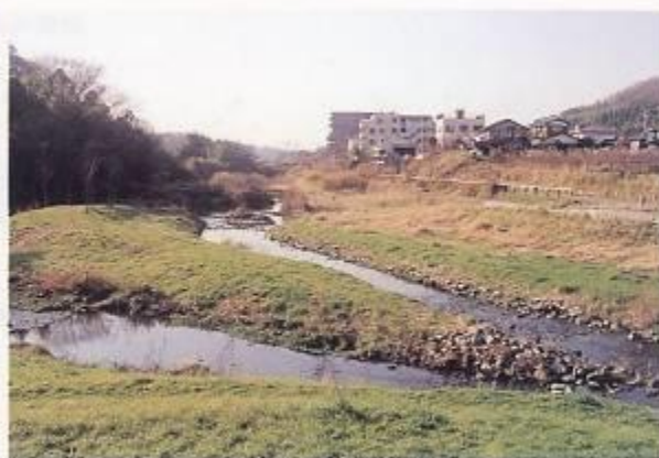
旧河道（手前）を保全しながら新河道をつくり、多様性のある水辺空間をつくり出している。 (神奈川・横浜市／独（いたち）川)
