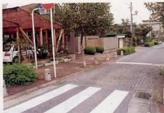
交差点にハンプを設置して車がスピードを出さないように喚起している。 (千葉市／本町)
