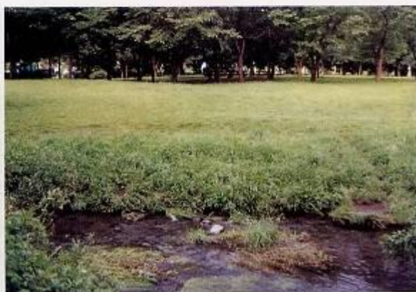
コンクリート護岸を土羽護岸に改良し、生き物が生息できる空間の創出を図っている。（神奈川・大和市／引地川）
