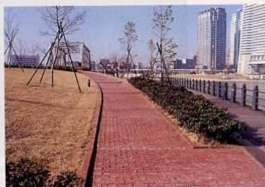
下水汚泥の焼却灰 100%のレンガを活用した園路。 (神奈川・横浜市／みなとみらい21・自動車道)
