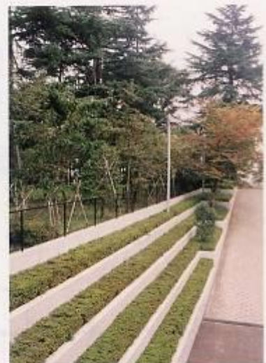
高低差の処理のために生じる擁壁の形態を工夫し、緑化することによってやさしい表情をつくっている。
