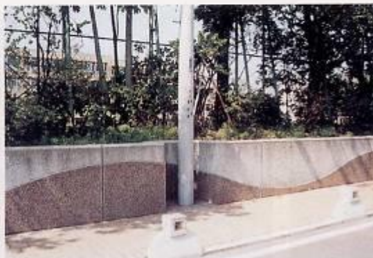
沿道の敷地内に電柱を設置し、歩道の有効幅員を広くしている。 (東京・世田谷区／玉川中学校)
