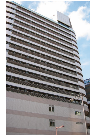
まちなみとの調和に配慮された立体駐車場
