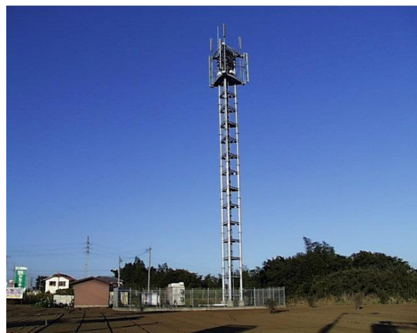
住宅に近く、道路から鉄塔全体が見えている。
