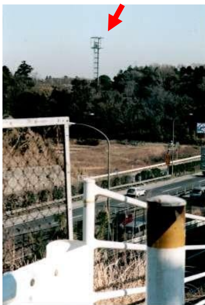
高木に囲まれ、比較の見えにくい場所に設置している。
