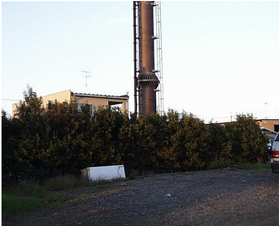
フェンスの外側に生垣を設置し、鉄塔の基礎部分やフェンスを隠している。 フェンスは茶系。
