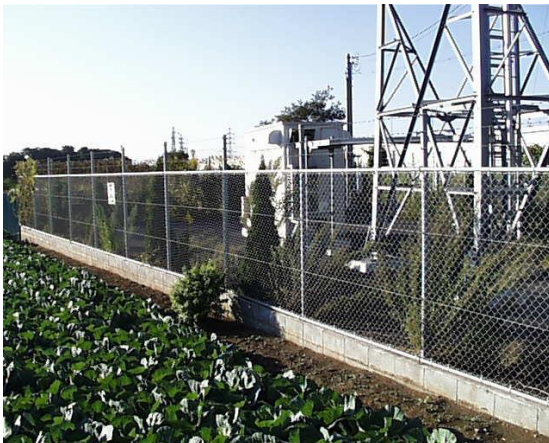
フェンスの内側に植栽しているが、本数が少ないため、目隠しになっていない。 フェンスもシルバー系で目立つ。
