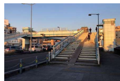
JR 蘇我駅西口歩道橋
