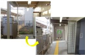
京成検見川駅(令和元年整備)
