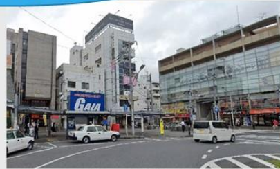
現状：民間建築物の老朽化
