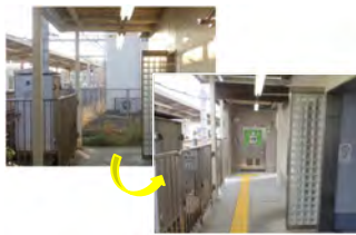
京成検見川駅(令和元年整備)
