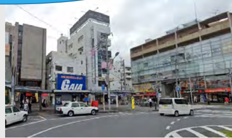
現状:民間建築物の老朽化
