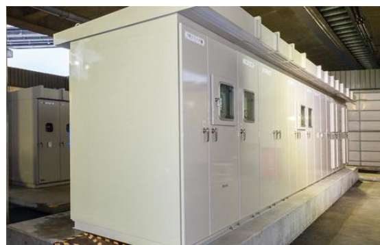
図 4-7 回生電力貯蔵装置設置イメージ
