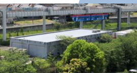
殿台変電所 回生電力貯蔵装置
