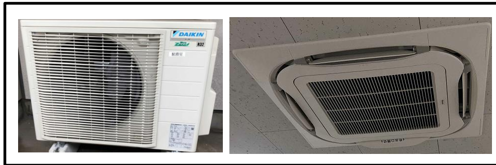
千葉駅(2021(R3)年度施工)
