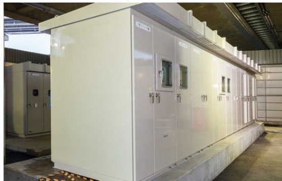
図 4-7 回生電力貯蔵装置設置イメージ
