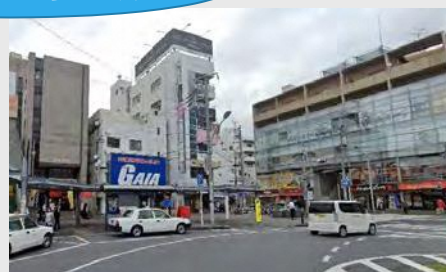
現状:民間建築物の老朽化
