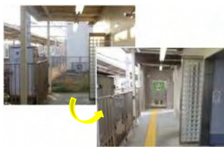
京成検見川駅（令和元年整備）
