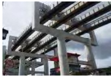
軌道桁・支柱
