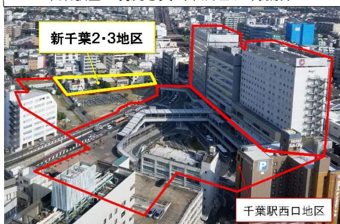
新千葉2・3地区現況写真（南側から 平成30年撮影）
