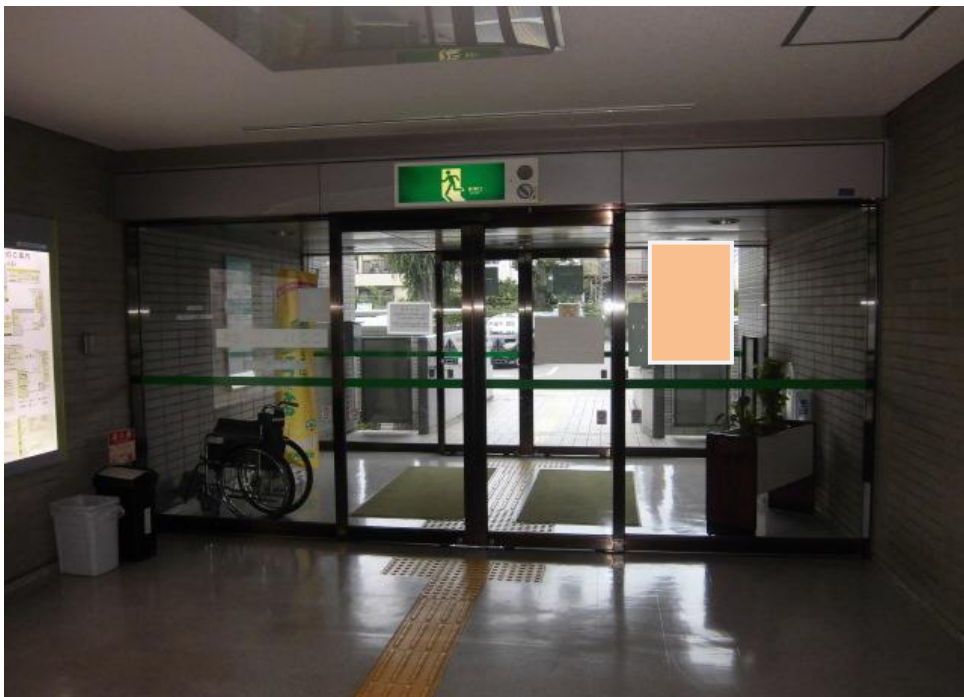
②区役所・2階駐車場側出入口自動ドアガラス面 (W450×H600) 1 枠
