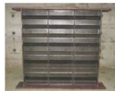
図 3：波形鋼板耐震壁
