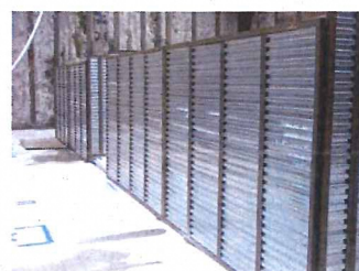
鋼製型枠採用例 ④
