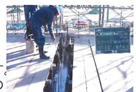
打継ぎ処理剤散布作業状況
