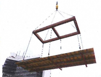
底の型枠ユニット化例 ⑥
