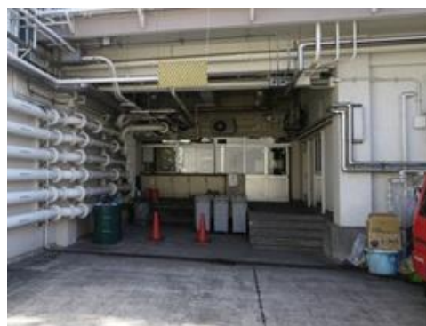
本庁舎地下1階出入口
