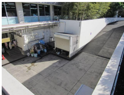
本庁舎地下1階へのスロープ
