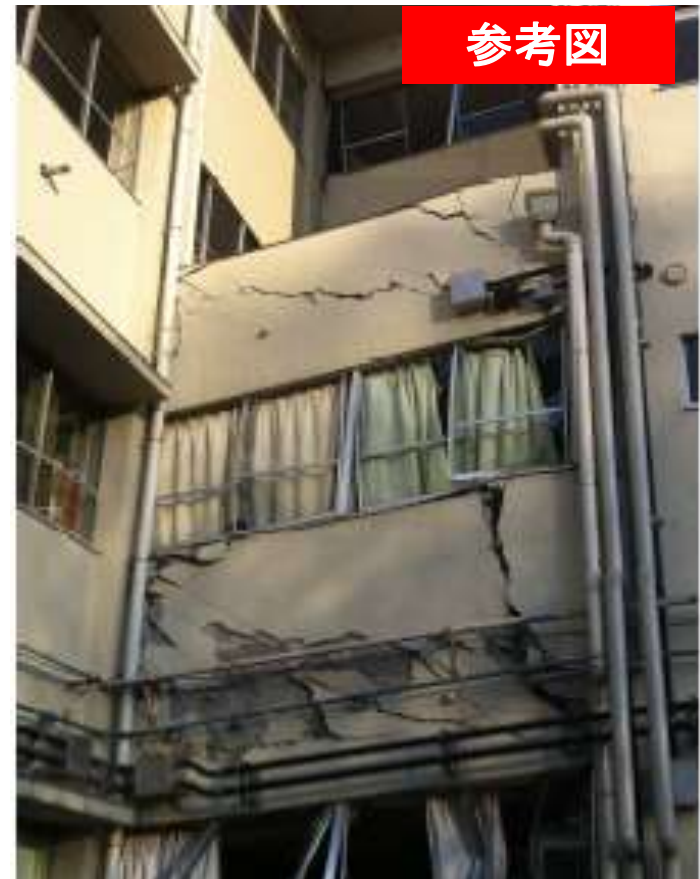
出典:さいたま市西区栄小 学校H.P. 3.11東日本大震災被害 昭和44年竣工
