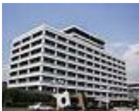
①千葉市役所本庁舎 議事堂棟
