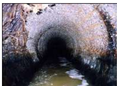
耐震性能が低下した管きよの耐震化の例（管更生工法）
