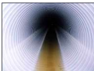
耐震性能が低下した管きよの耐震化の例（管更生工法）
