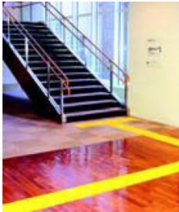
床の素材を変え、歩行感により空間を認識しやすくする (千葉市：ハーモニープラザ)
