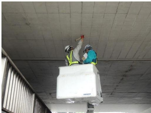
打音検査\*による点検状況。
