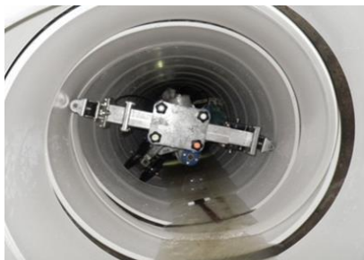
管渠改築事業
