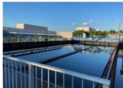
浄化センター整備事業
