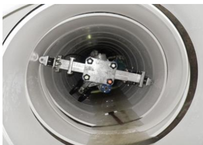
管渠改築事業
