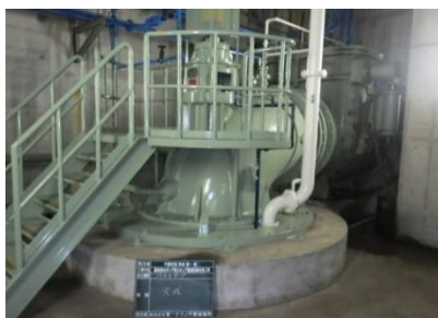
ポンプ場整備事業
