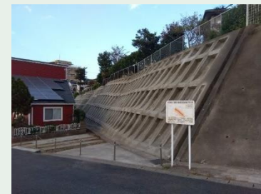
▼稲毛東2丁目 (施工後)
