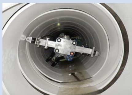
管渠改築事業
