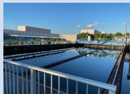
浄化センター整備事業
