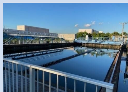
浄化センター整備事業
