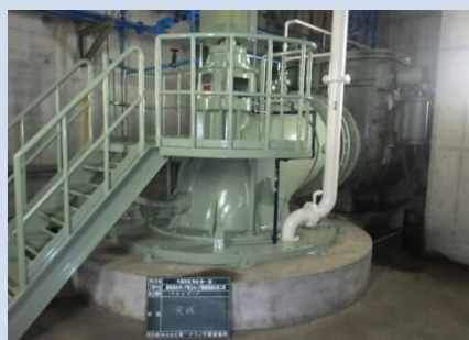
ポンプ場整備事業
