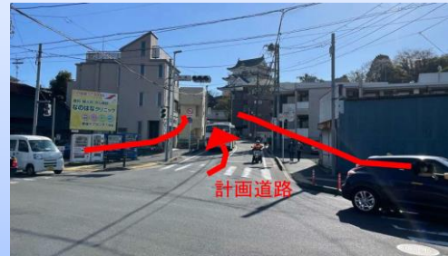
(旭橋から国道16号方面の事業区間)
