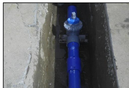
(水道管路 布設状況)
