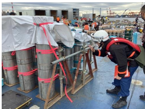
(煙火設置状況の現地調査)
