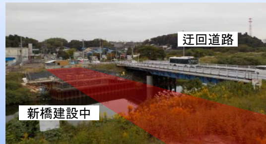
(亥鼻橋の状況 (河口から約6km))
