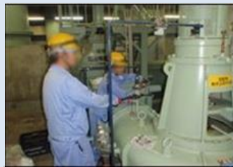
(南部浄化センター：点検整備)
