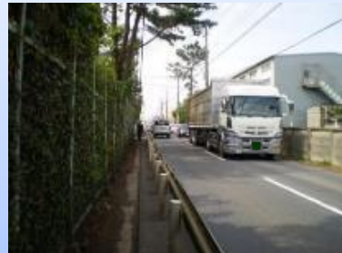
(幅員が狭く、歩道の分離も不十分)
