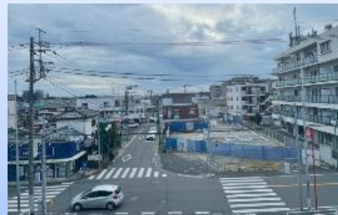
(南口駅前広場の状況)
