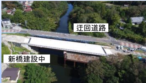
(柏井橋の状況 (河口から約9km))
