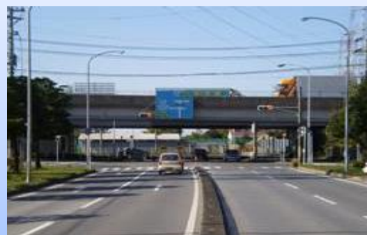
（国道16号付近の整備済み区間）
