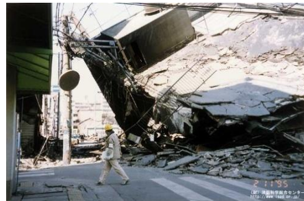
阪神淡路大震災被害による道路閉塞の様子
