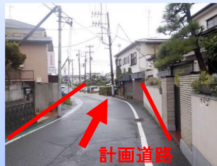
(国道16号方面から(主)千葉大網線方面の事業区間)
