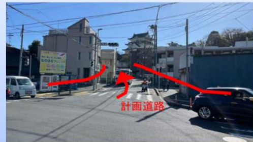
(旭橋から国道16号方面の事業区間)
