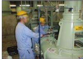
南部浄化センター：点検整備
