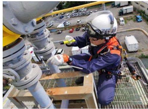
(高圧ガスの現場検査)
