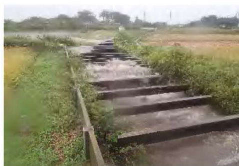
(大雨時の宇那谷2号排水路)
