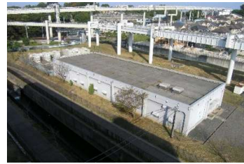
殿台変電所設備
