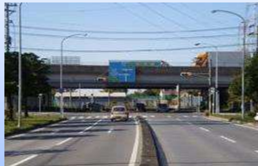
(国道16号付近の整備済み区間)
