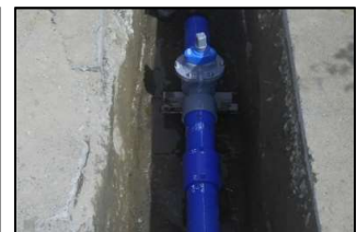
<水道管路 更新後>
