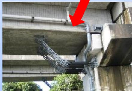
橋桁が落下しないようにチェーンなどで連結しています。
