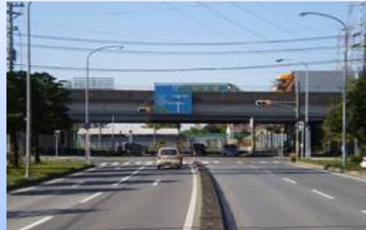
(国道16号付近の整備済み区間)
