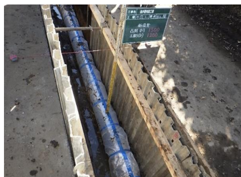
配水管の布設工事
