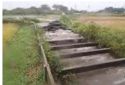
(大雨時の宇那谷2号排水路)
