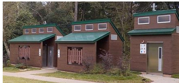
トイレの改修状況（泉自然公園）
