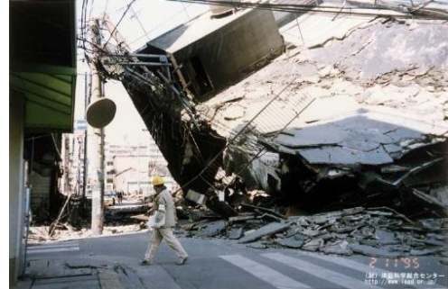
阪神淡路大震災被害による道路閉塞の様子
