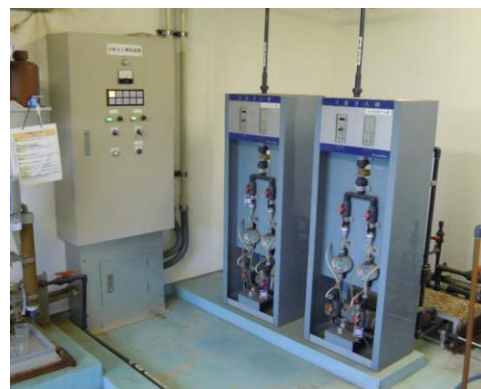
機械設備の改築更新
