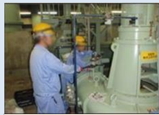
(南部浄化センター:点検整備)
