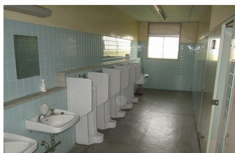
トイレを改修する前
